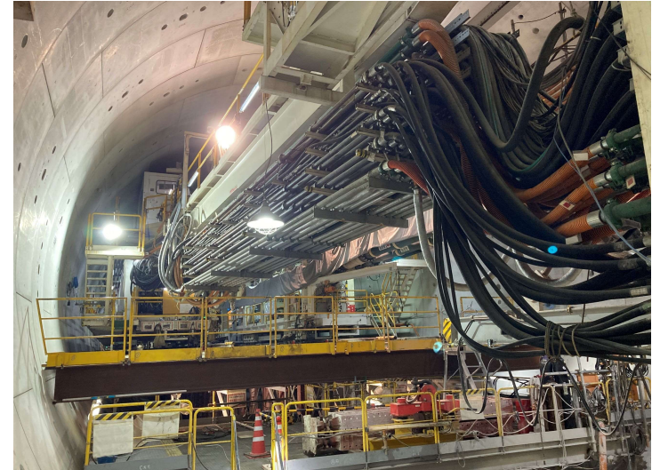
② 高速 5 号線シールドトンネル掘削他工事
