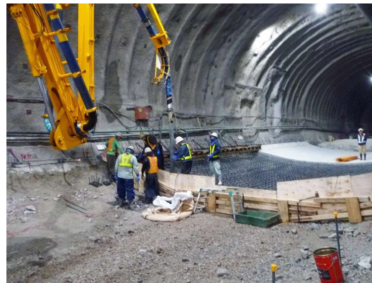
④ 高速 5 号線 NATM トンネル工事
