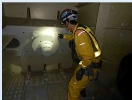
高速4号線橋梁点検の状況
