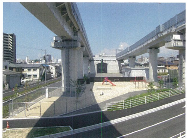
高架下利用(東雲地区)
