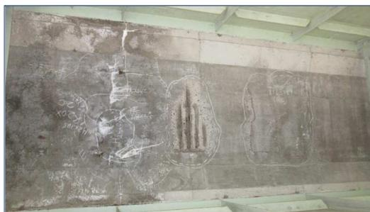
〔損傷例（床版 漏水及び鉄筋露出）〕
