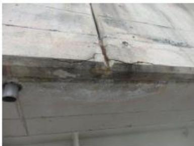
壁高欄～床版水切り部周辺に見られる損傷例
