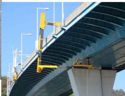
写真2.5.7 橋梁点検車による点検状況
