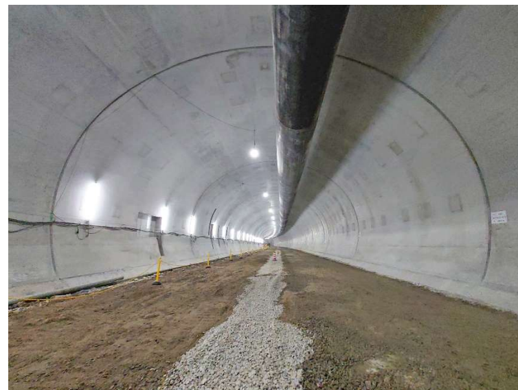
④ 高速 5 号線 NATM トンネル工事
