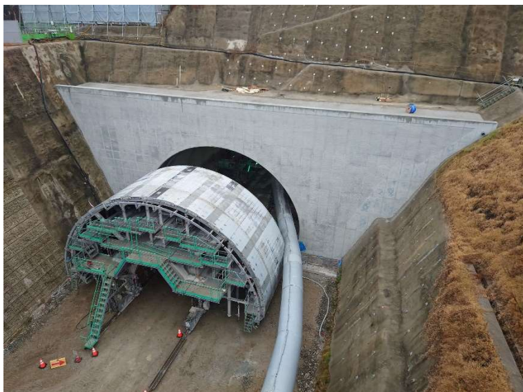
③ 高速 5 号線 NATM トンネル工事
