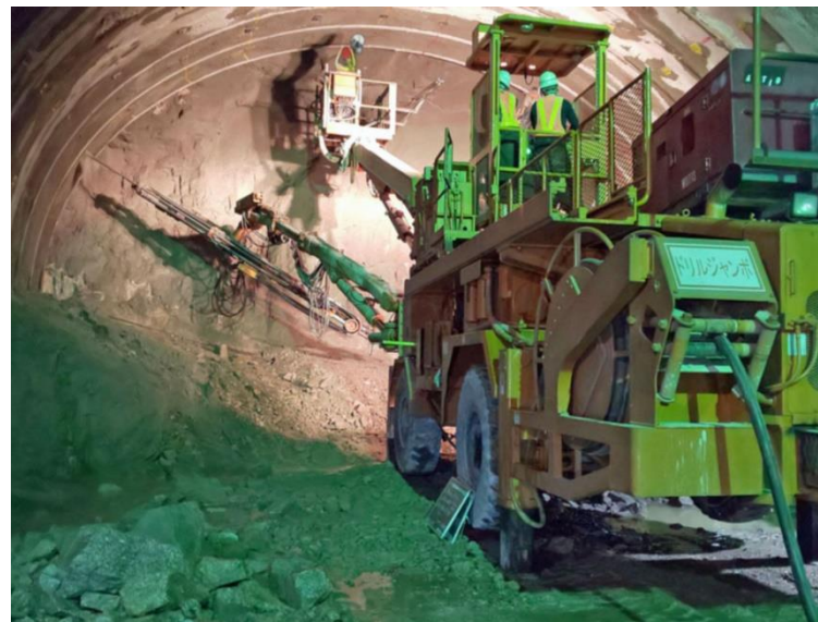
④ 高速5号線 NATM トンネル工事
