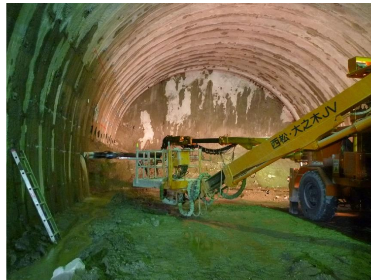
④ 高速5号線 NATM トンネル工事
