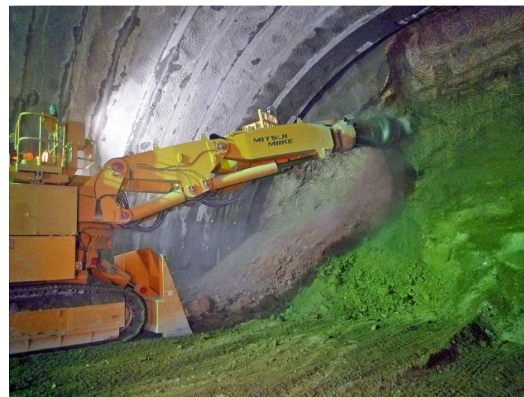
④ 高速5号線 NATM トンネル工事
