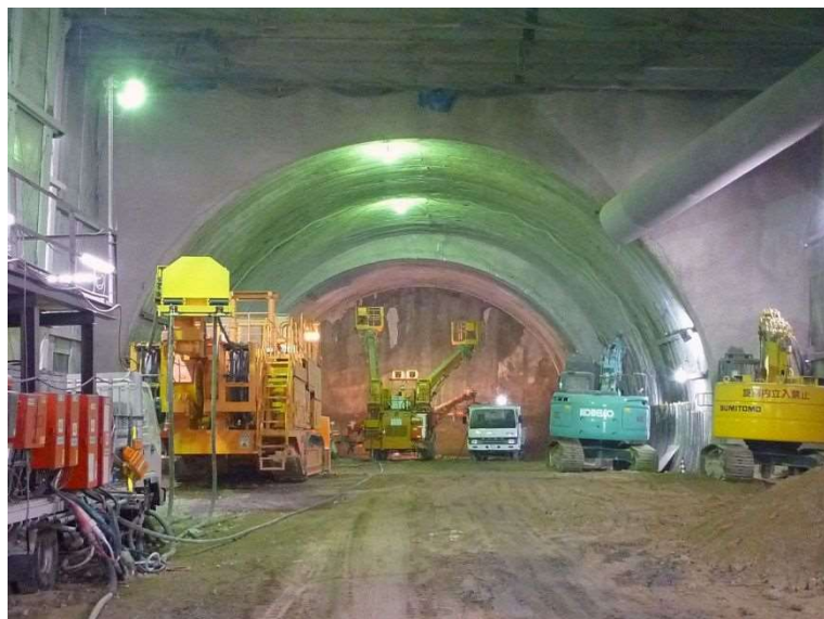
③ 高速 5 号線 NATM トンネル工事
