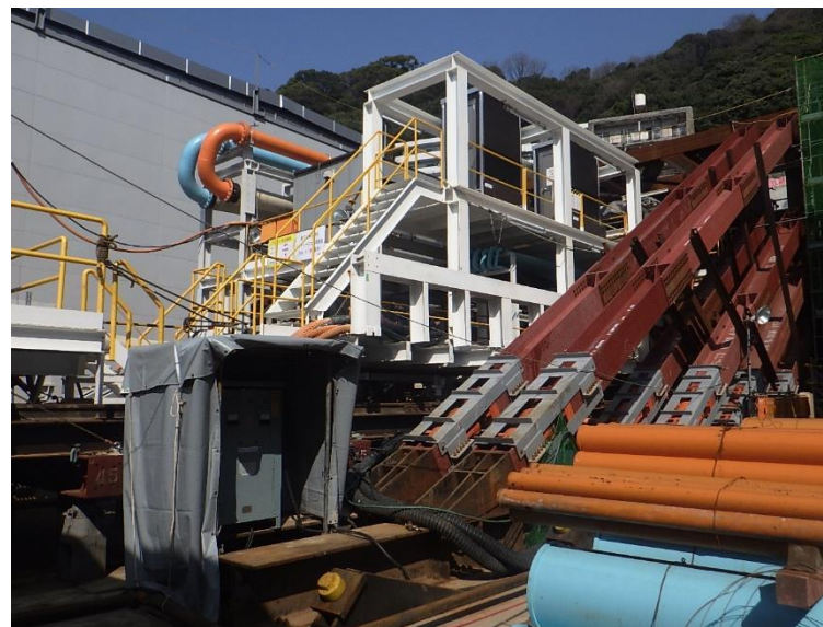
② 高速5号線シールドマシン製作他工事
