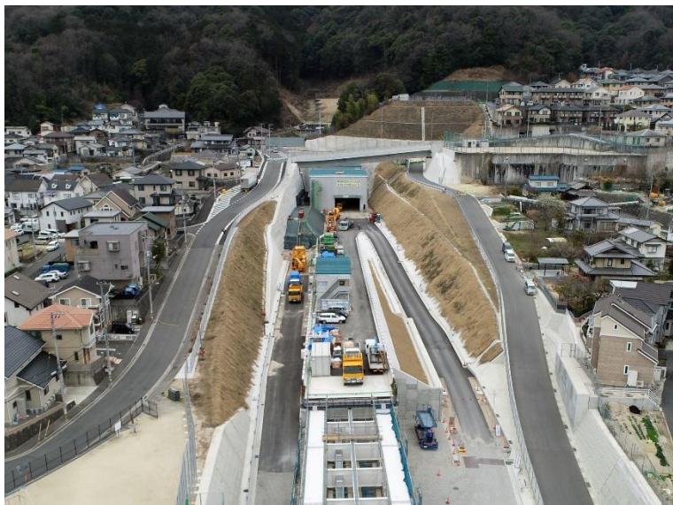
③ 高速5号線 NATM トンネル工事
