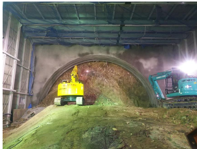
④ 高速5号線 NATM トンネル工事
