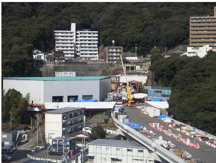
① 高速5号線シールドマシン製作他工事
