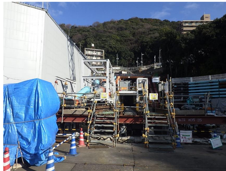
② 高速5号線シールドマシン製作他工事
