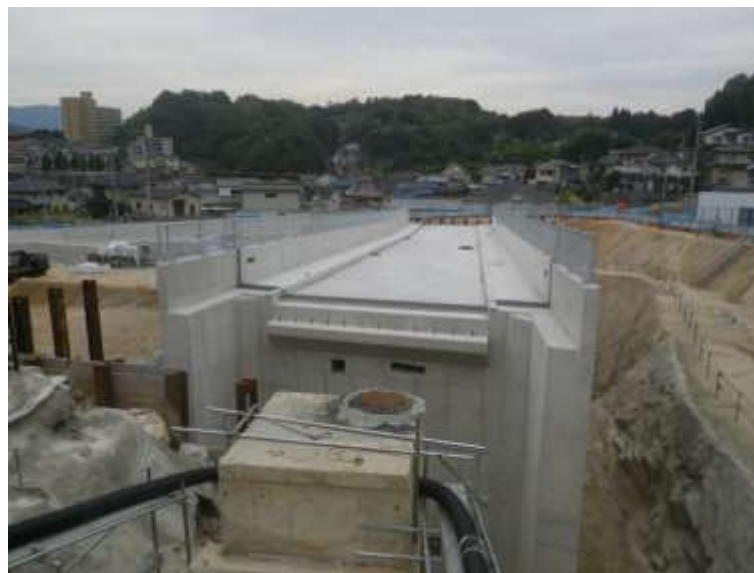
⑥ 中山地区跨道橋上部工事
