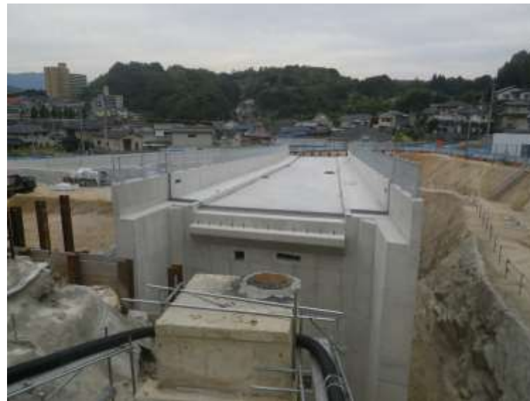
⑥ 中山地区跨道橋上部工事
