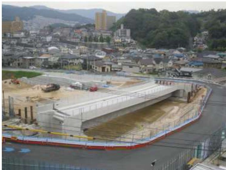
⑤ 中山地区跨道橋上部工事
