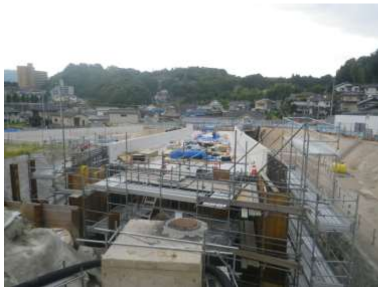
⑥ 中山地区跨道橋上部工事
