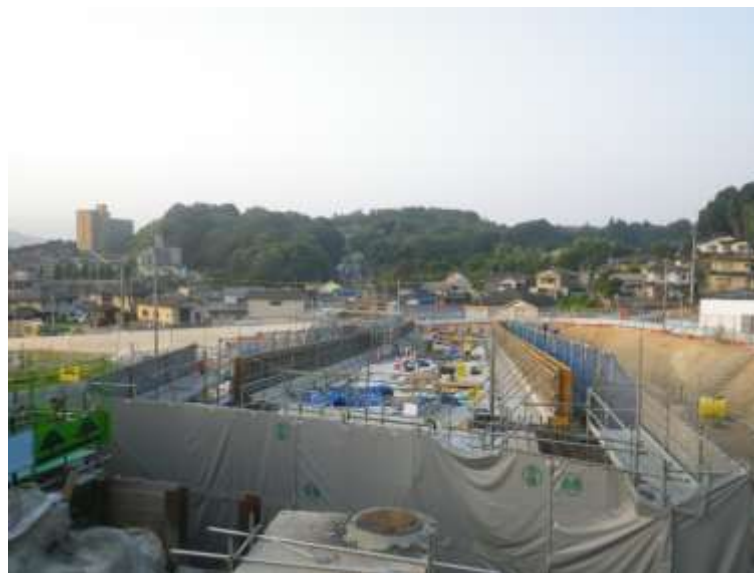
⑥ 中山地区跨道橋上部工事
