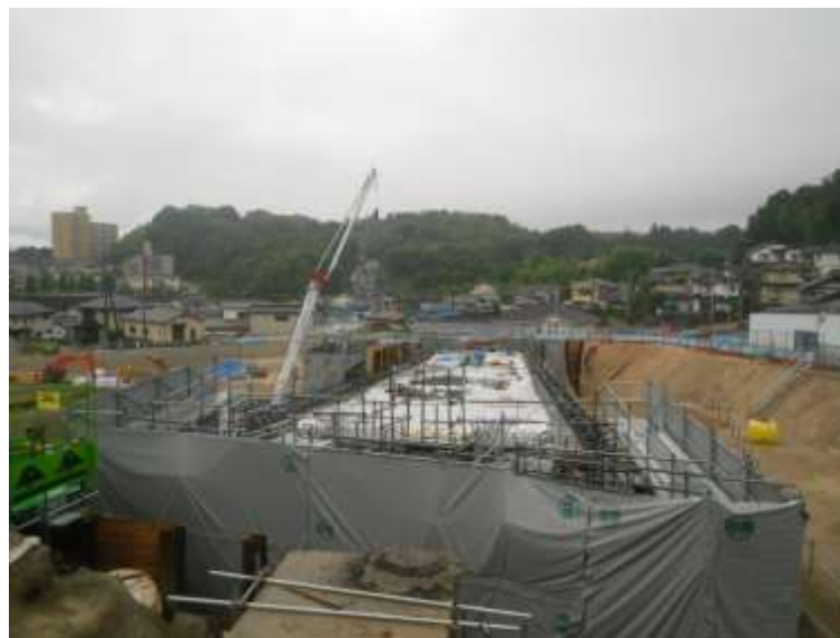
⑥ 中山地区跨道橋上部工事
