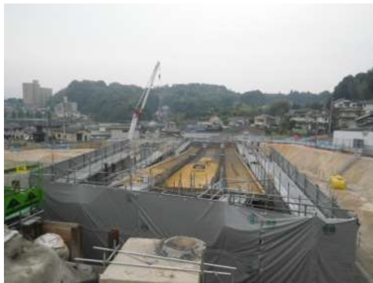
⑥ 中山地区跨道橋上部工事
