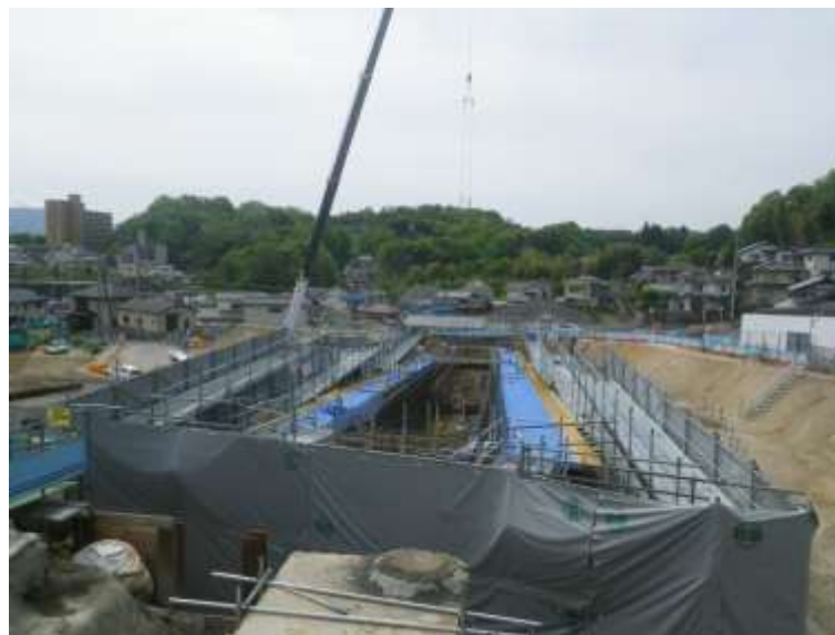
⑥ 中山地区跨道橋上部工事
