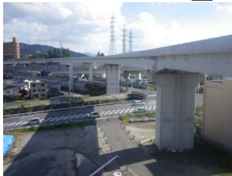
⑩ 高速5号線鋼上部工事 (温品 JCT) 完成
