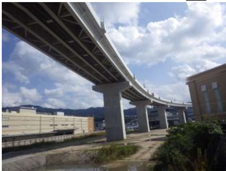
⑨ 高速5号線鋼上部工事 (温品 JCT) 完成
