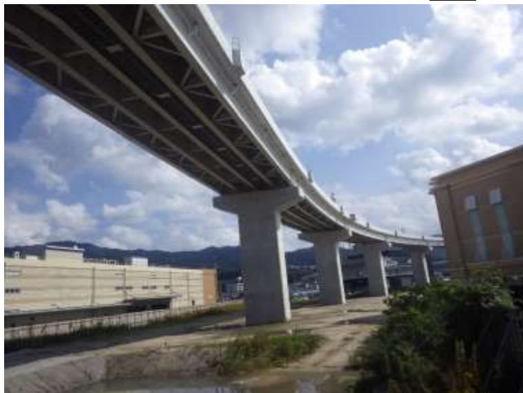
⑦ 高速5号線鋼上部工事 (温品 JCT) 完成
