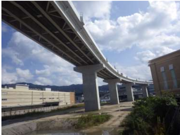
⑤ 高速5号線鋼上部工事 (温品JCT)
