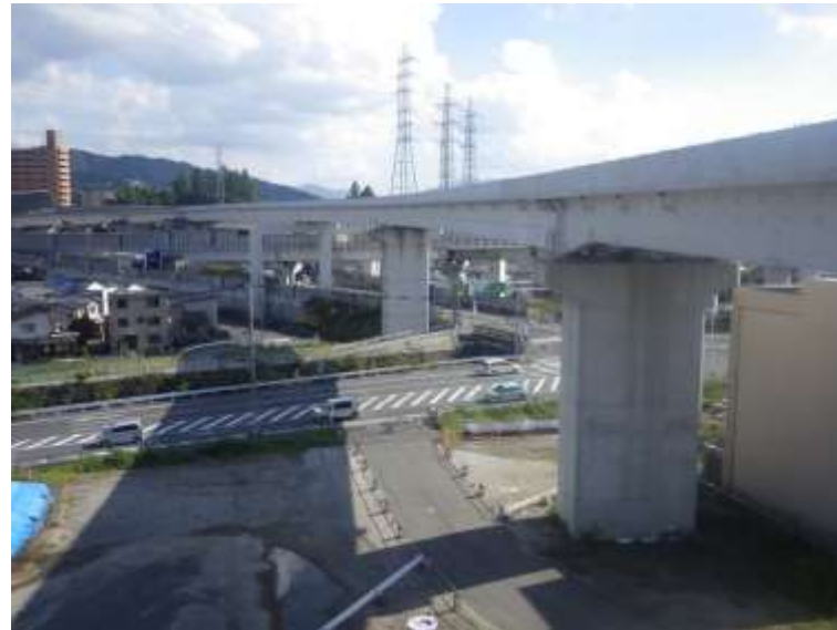
⑥ 高速5号線鋼上部工事 (温品JCT)
