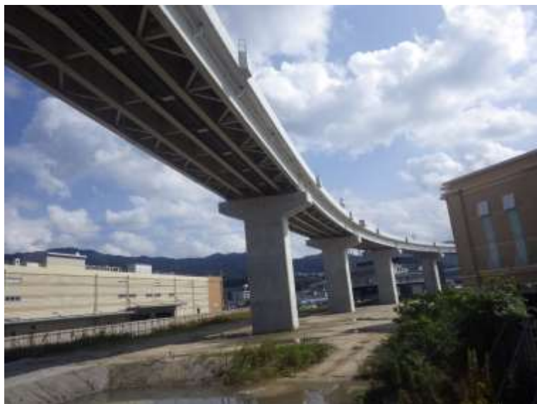
⑤ 高速5号線鋼上部工事 (温品JCT)
