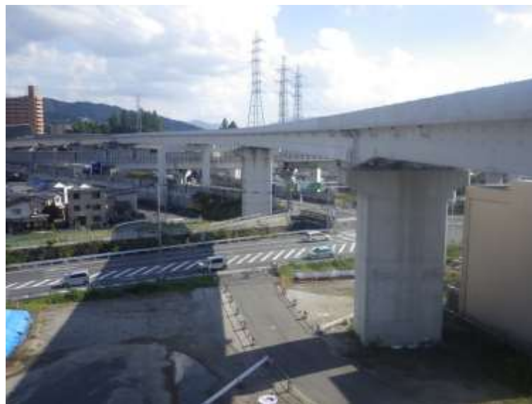
⑥ 高速5号線鋼上部工事 (温品JCT)
