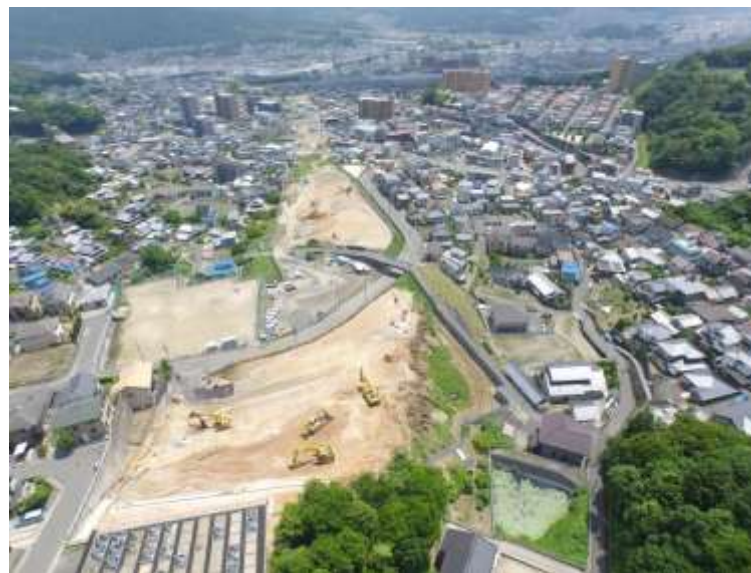
⑥ 高速5号線道路新設工事 (中山IC)
