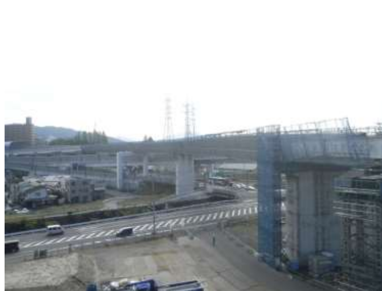
④ 高速5号線鋼上部工事 (温品JCT)
