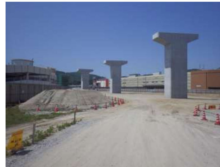
④ 高速5号線下部工事 (温品JCT)
