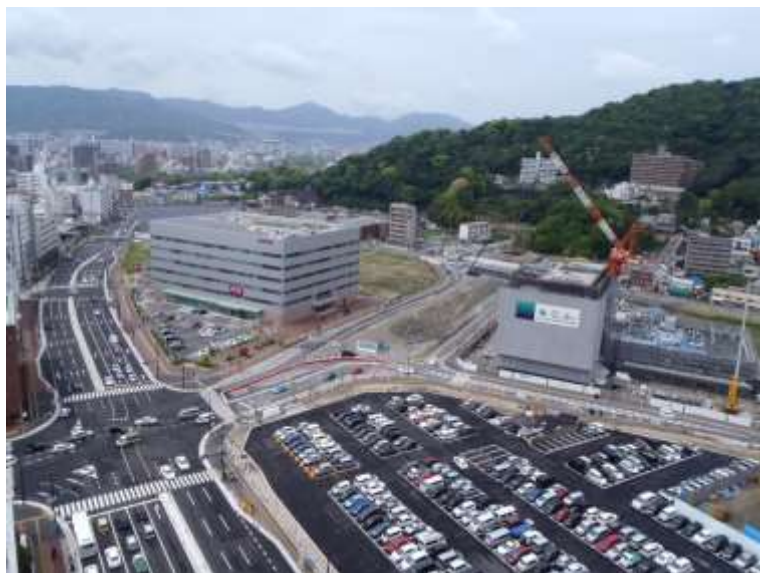
① 高速5号線下部工事 (二葉の里)
