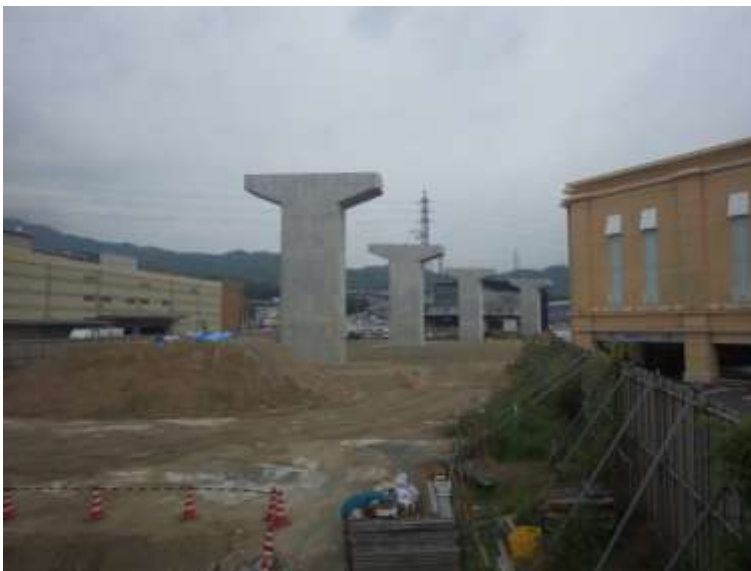
④ 高速5号線下部工事 (温品 JCT)
