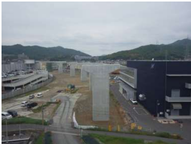
③ 高速5号線下部工事 (温品 JCT)
