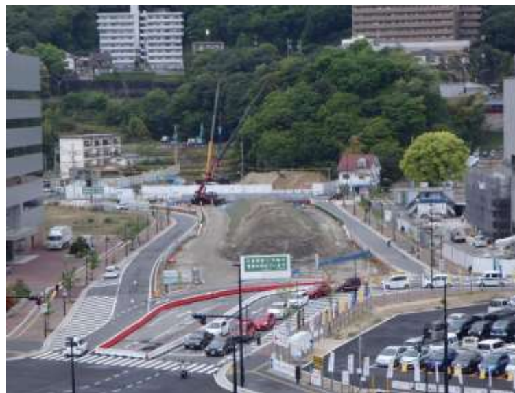
② 高速5号線下部工事 (二葉の里)
