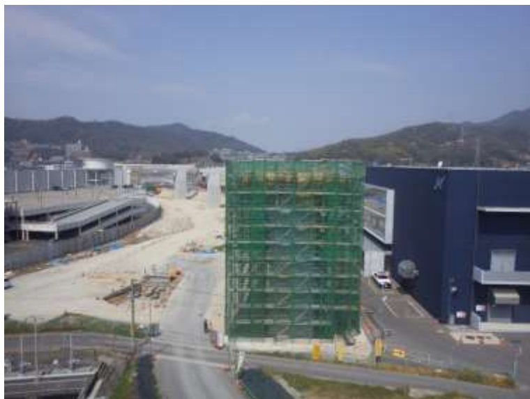
① 高速5号線下部工事 (温品 JCT)
