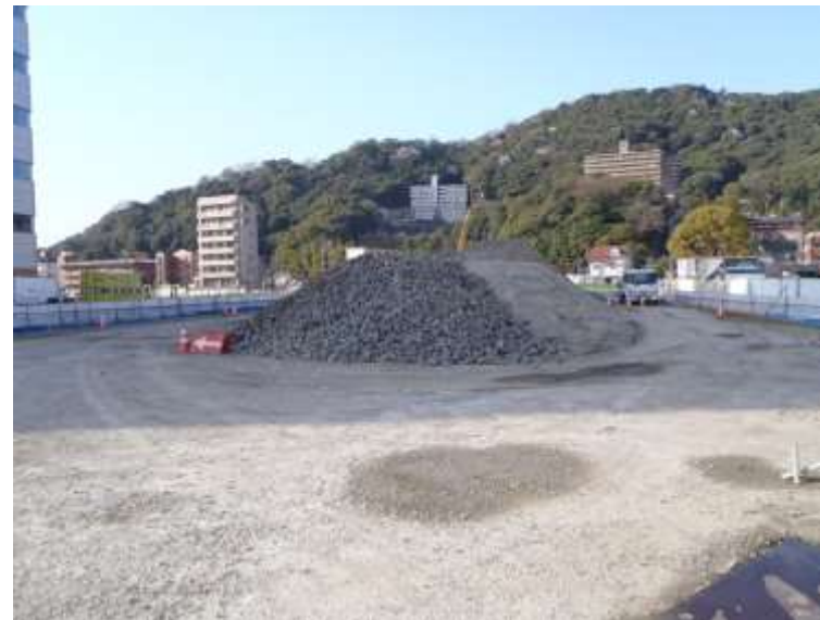
⑤ 高速5号線下部工事 (二葉の里)
