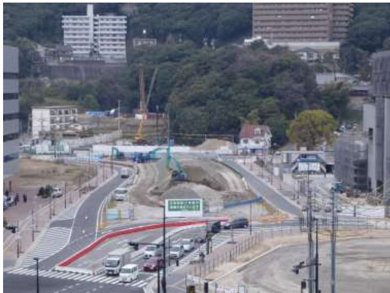
④ 高速5号線下部工事 (二葉の里)
