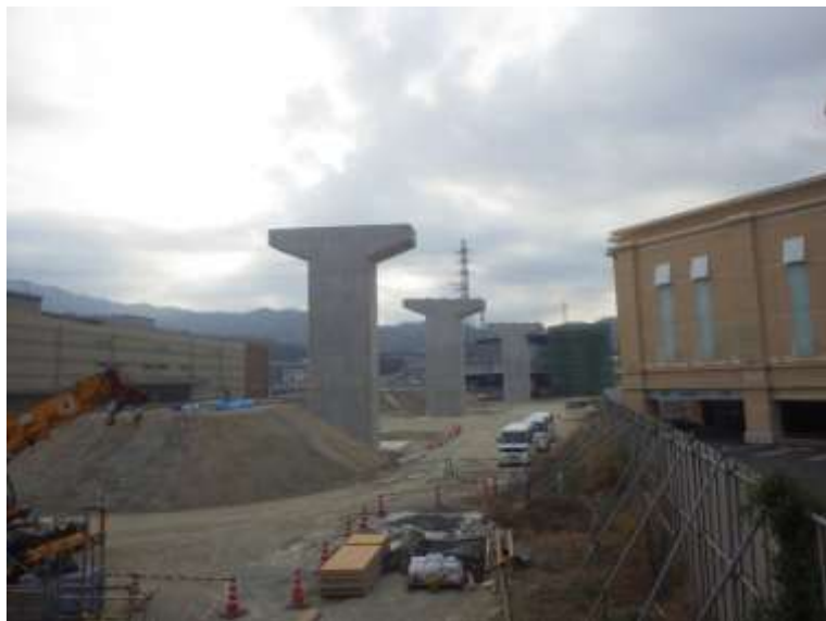
③ 高速5号線下部工事 (温品 JCT)
