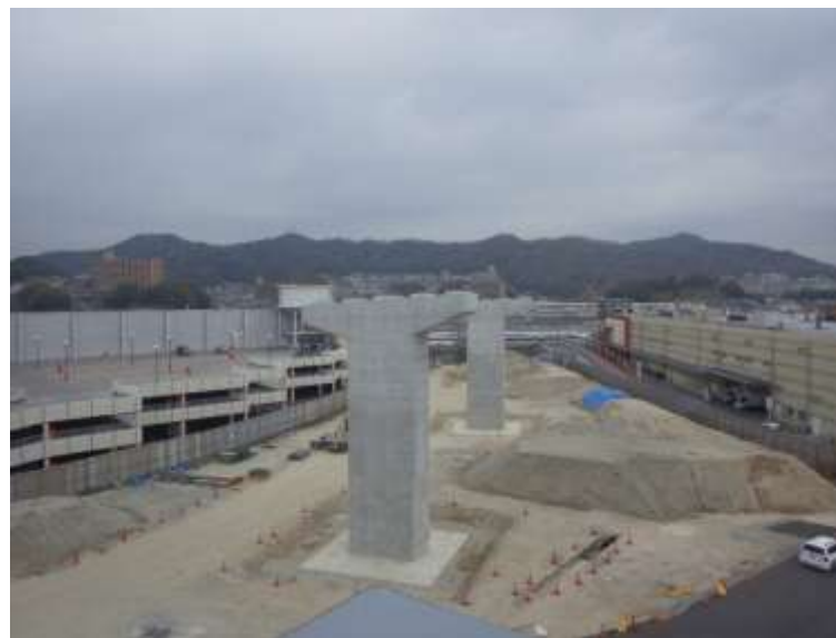
② 高速5号線下部工事 (温品 JCT)
