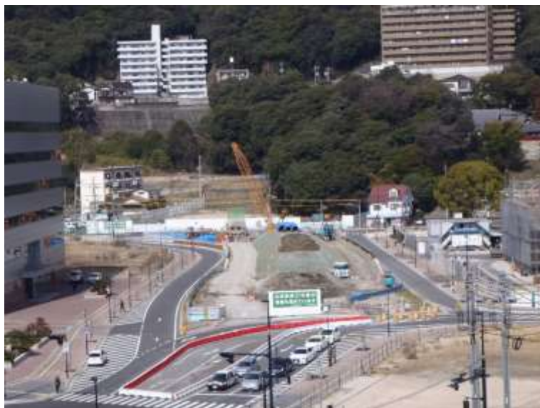
④ 高速5号線下部工事 (二葉の里)
