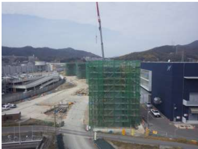
① 高速5号線下部工事 (温品 JCT)
