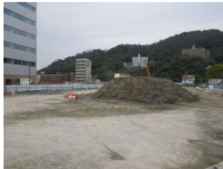
⑤ 高速5号線下部工事 (二葉の里)
