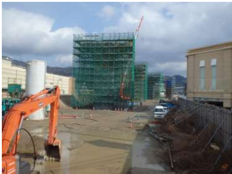
③ 高速5号線下部工事 (温品 JCT)
