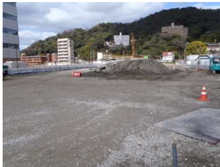
⑤ 高速5号線下部工事 (二葉の里)
