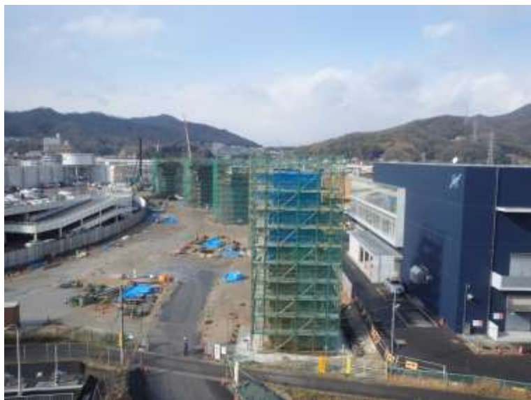
① 高速5号線下部工事 (温品 JCT)
