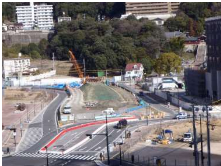
④ 高速5号線下部工事 (二葉の里)
