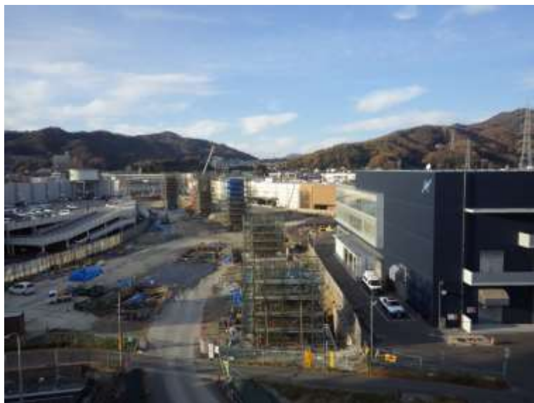
① 高速 5 号線下部工事 (温品 JCT)
