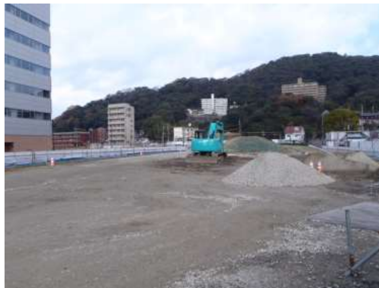
⑤ 高速5号線下部工事 (二葉の里)
