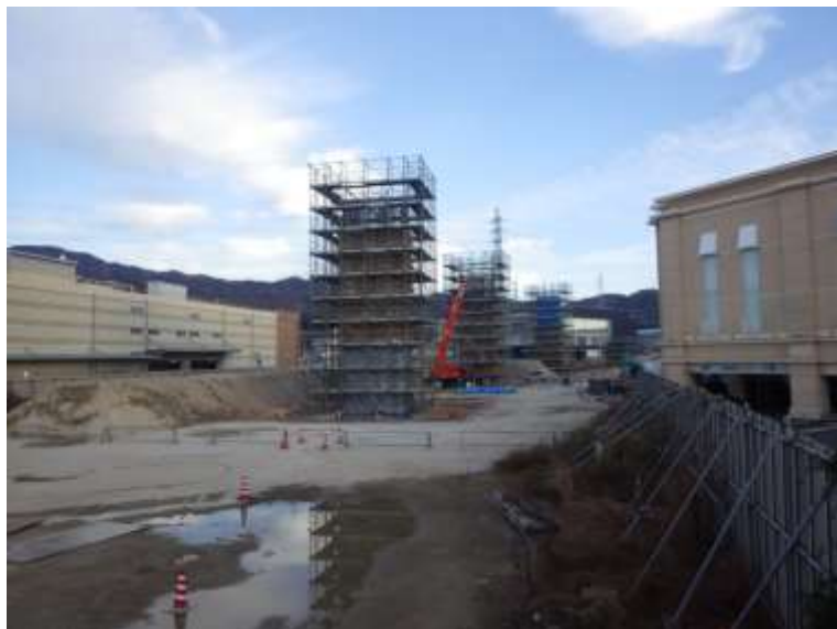
③ 高速 5 号線下部工事 (温品 JCT)
