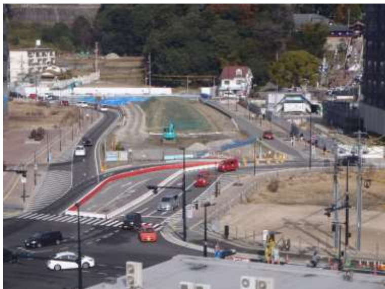
④ 高速5号線下部工事 (二葉の里)
