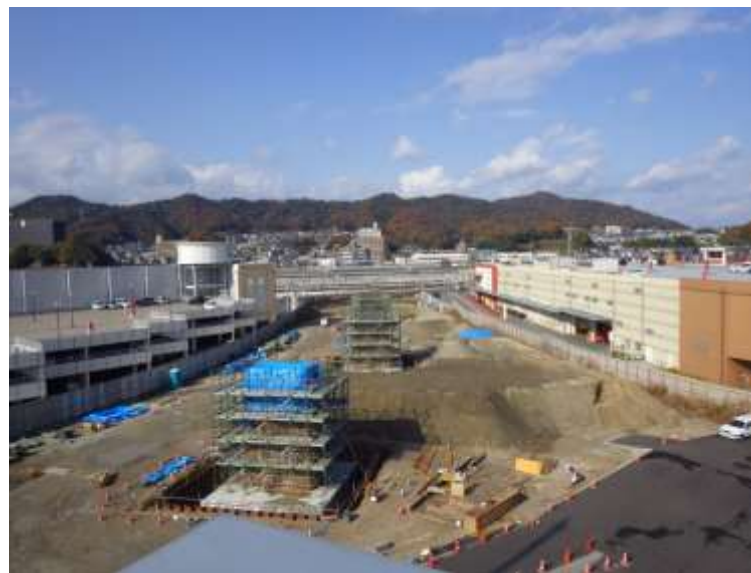
② 高速5号線下部工事 (温品 JCT)
