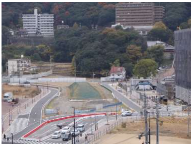
④ 高速5号線下部工事 (二葉の里)
