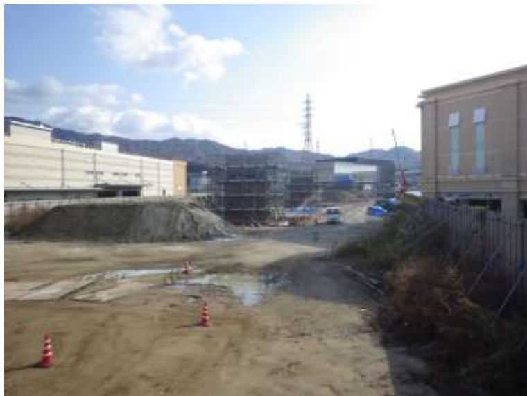
③ 高速5号線下部工事 (温品 JCT)
