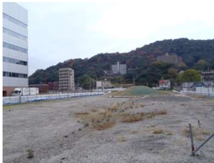
⑤ 高速5号線下部工事 (二葉の里)
