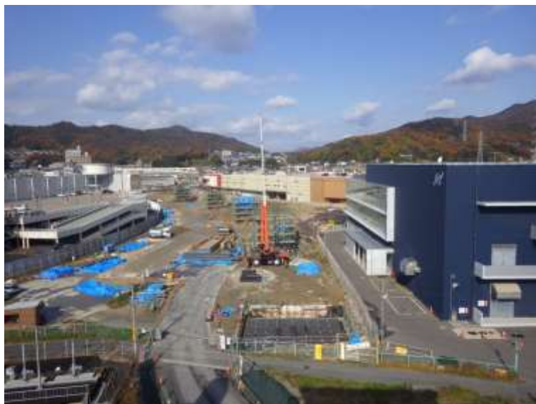
① 高速5号線下部工事 (温品 JCT)
