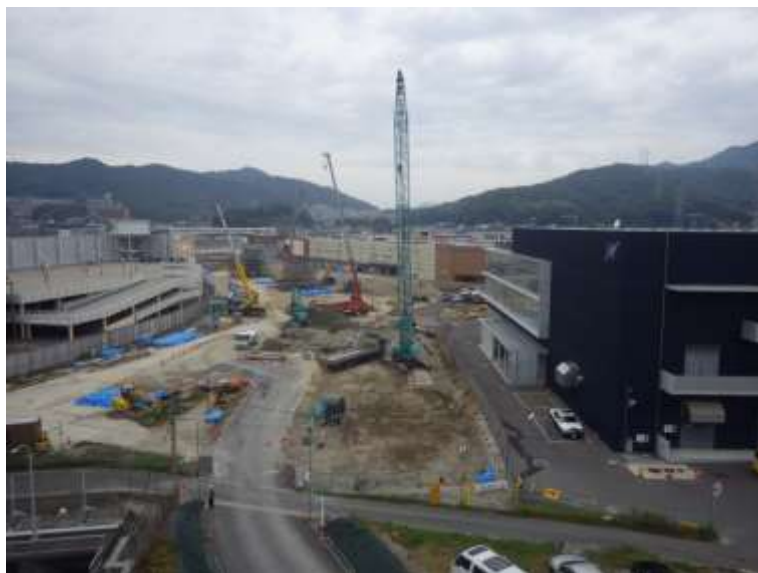
① 高速5号線下部工事 (温品 JCT)
