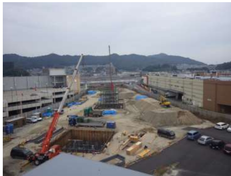
② 高速5号線下部工事 (温品 JCT)
