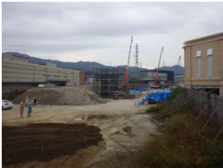
③ 高速5号線下部工事 (温品 JCT)
