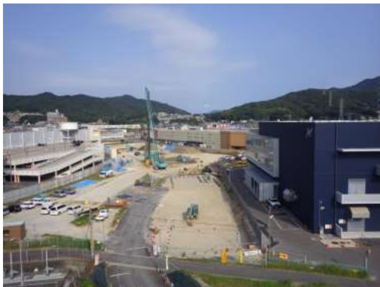
① 高速 5 号線下部工事 (温品 JCT)
