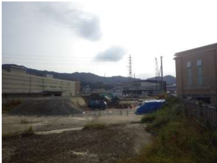
③ 高速 5 号線下部工事 (温品 JCT)
