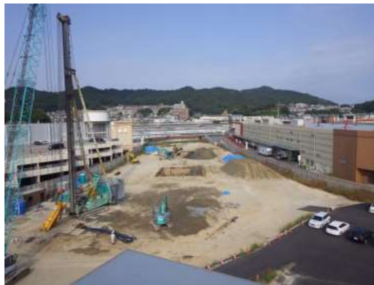
② 高速 5 号線下部工事 (温品 JCT)
