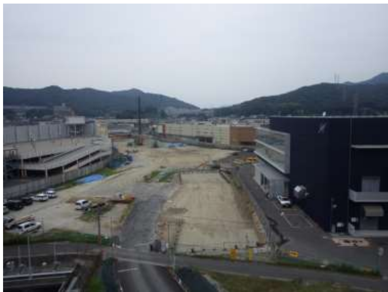
① 高速5号線下部工事 (温品 JCT)
