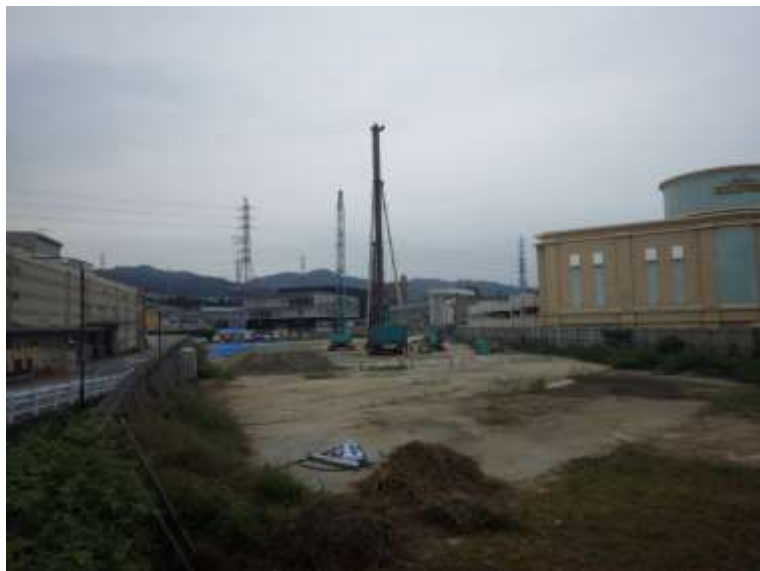
③ 高速5号線下部工事 (温品 JCT)
