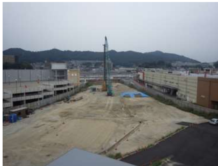
② 高速5号線下部工事 (温品 JCT)
