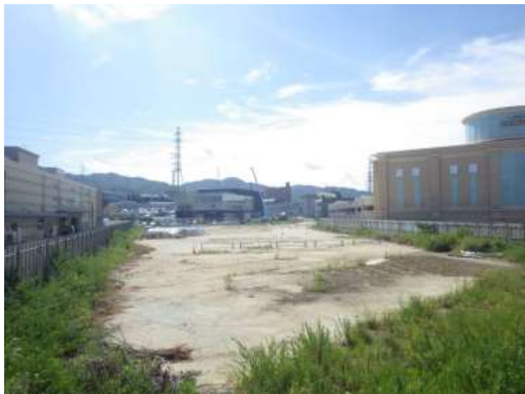
③ 高速5号線下部工事 (温品 JCT)
