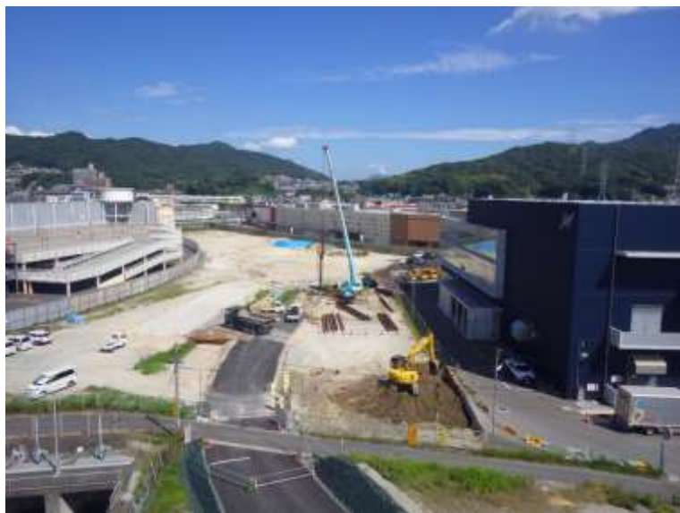
① 高速5号線下部工事 (温品 JCT)
