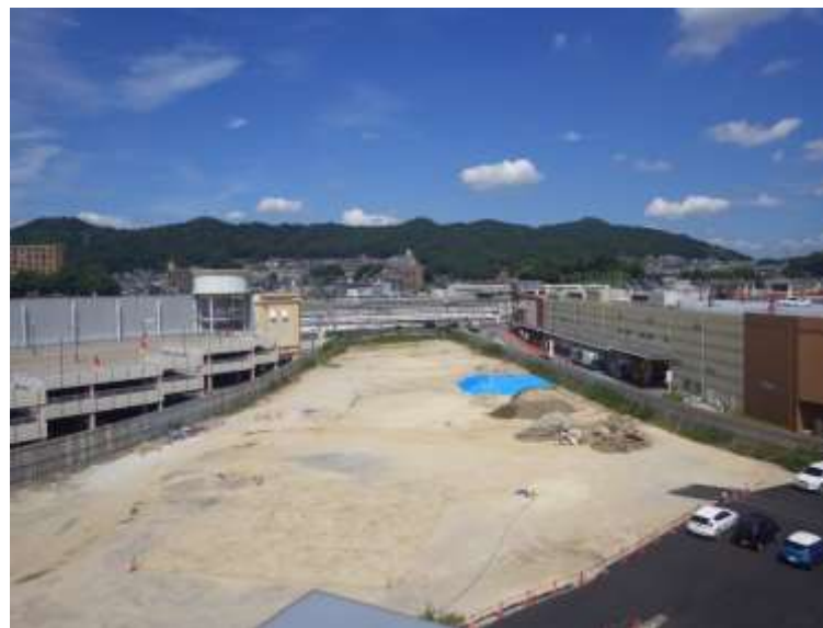
② 高速5号線下部工事 (温品 JCT)
