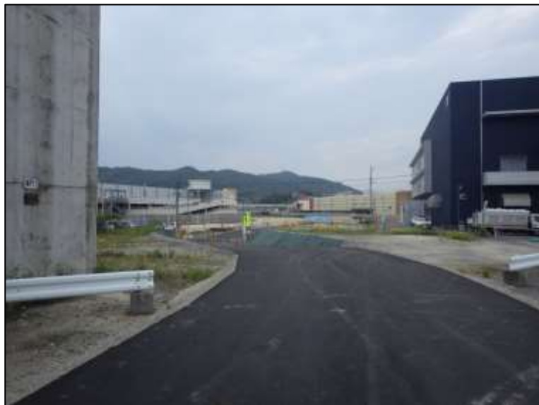
① 高速5号線下部工事 (温品 JCT)
