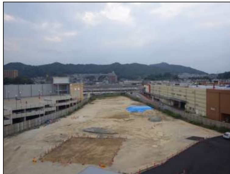
② 高速5号線下部工事 (温品 JCT)
