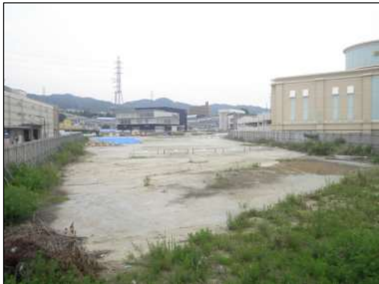
③ 高速5号線下部工事 (温品 JCT)
