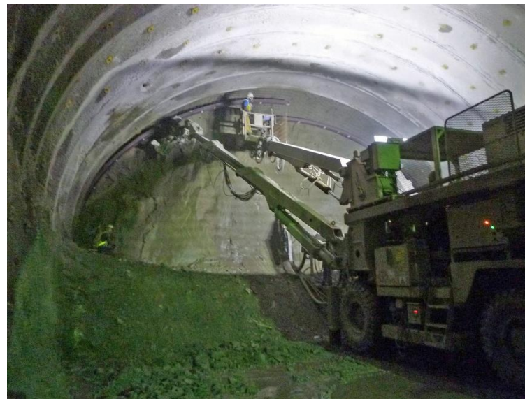
④ 高速5号線 NATM トンネル工事
