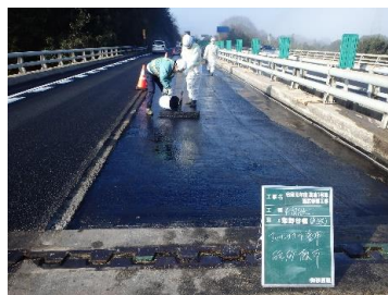
舗装修繕(床版防水)の事例
