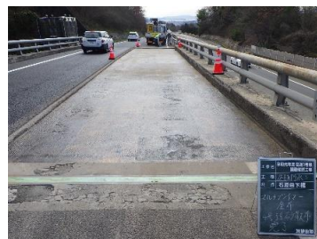
舗装修繕(床版防水)の事例
