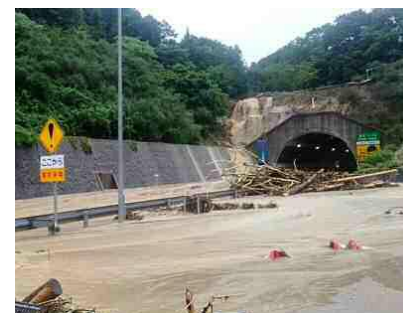
平成30年7月豪雨の被災状況
