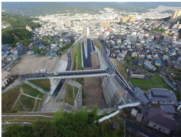
写真② 中山出入路周辺 (H30.8時点)
