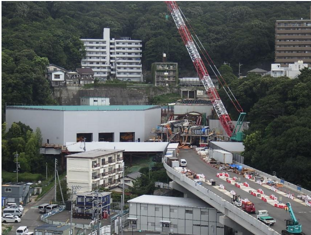
写真① 広島駅北口周辺 (H30.8時点)
