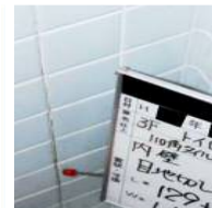
建物内部（例：壁）
