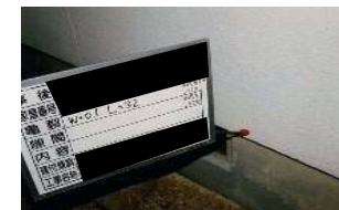
建物内部（例：外壁面）
