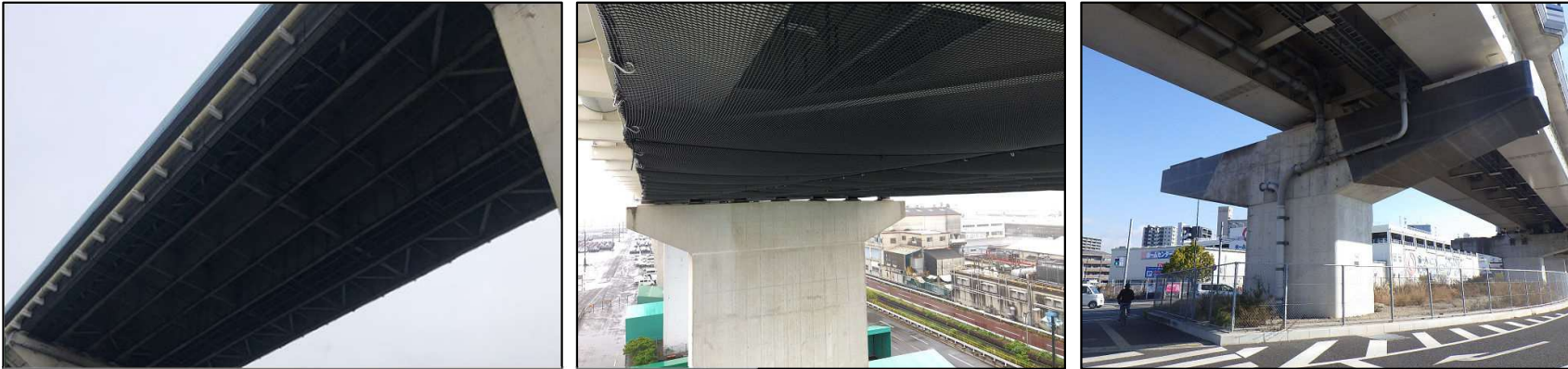
写真：広島高速道路3号線における対策事例
