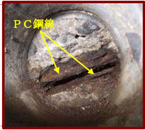
■ PC鋼線の腐食 (コア採取)
