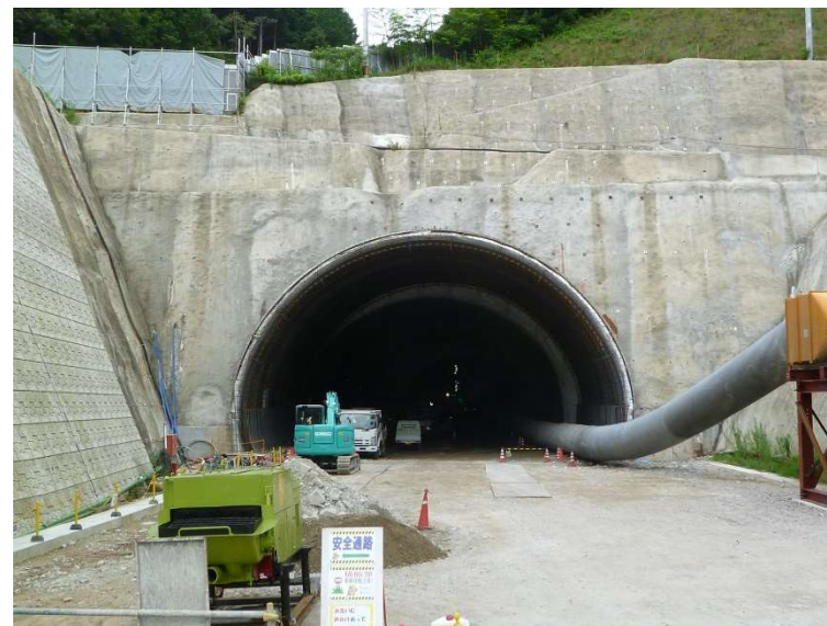
④ 高速 5 号線 NATM トンネル工事
