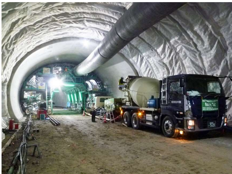
③ 高速 5 号線 NATM トンネル工事
