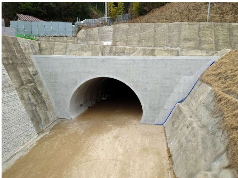
③ 高速 5 号線 NATM トンネル工事
