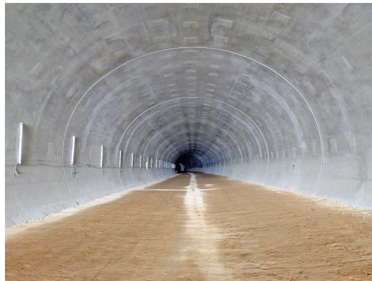
④ 高速 5 号線 NATM トンネル工事
