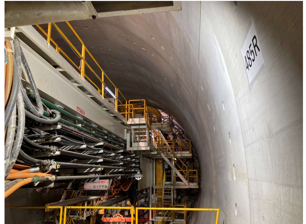
② 高速 5 号線シールトトンネル掘削他工事
