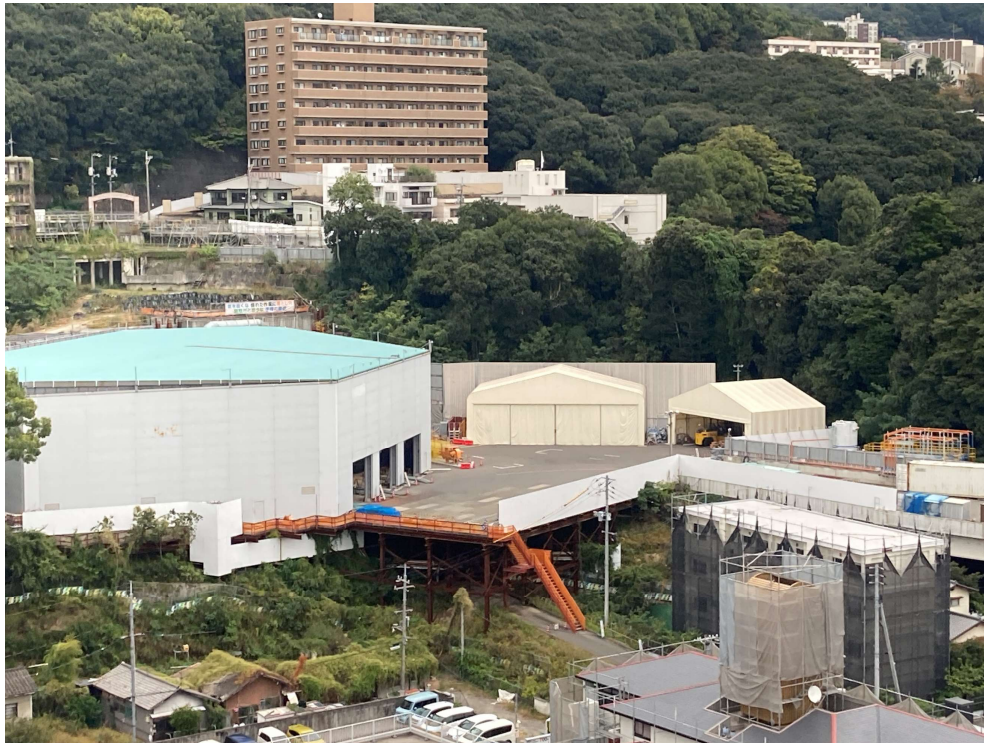
① 高速 5 号線シールトトンネル掘削他工事
