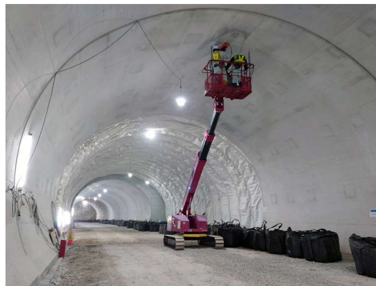
④ 高速 5 号線 NATM トンネル工事
