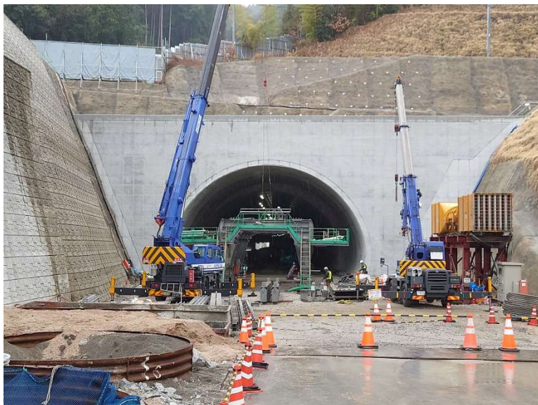
③ 高速 5 号線 NATM トンネル工事
